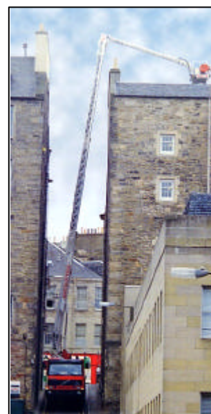
Bild 14: Gelenkig in engen Gassen. (Quelle Bronto Skylift)
