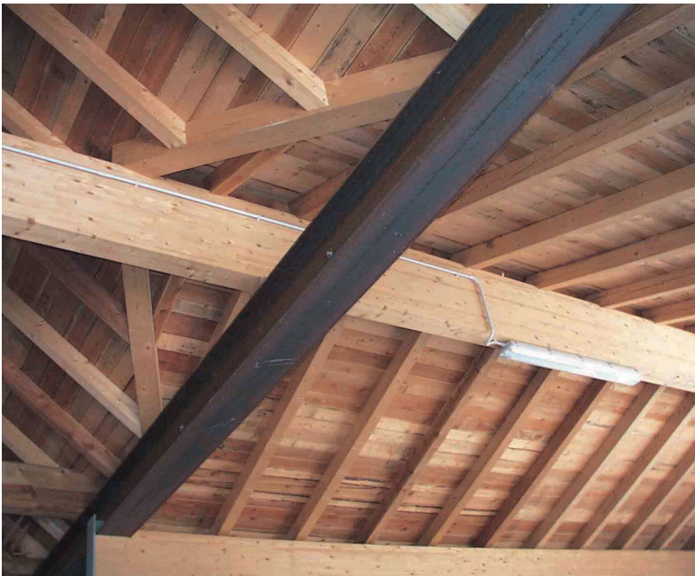
Abb. 18 - Im Vergleich zu Holz hat Stahl einen geringeren Feuerwiderstand
