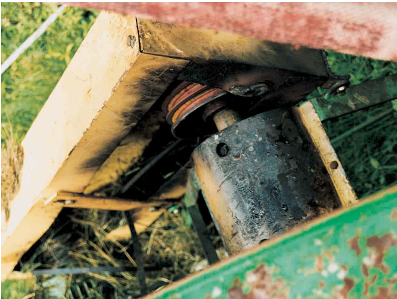
Abb. 5 - Keilriemenschutz darf nicht an der Riemenscheibe scheuern (Gefahr der Staubexplosion)
